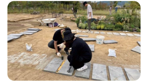
동선 판석 설치
